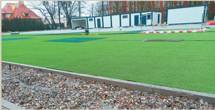
Montaż sztucznej trawy wraz z liniami
