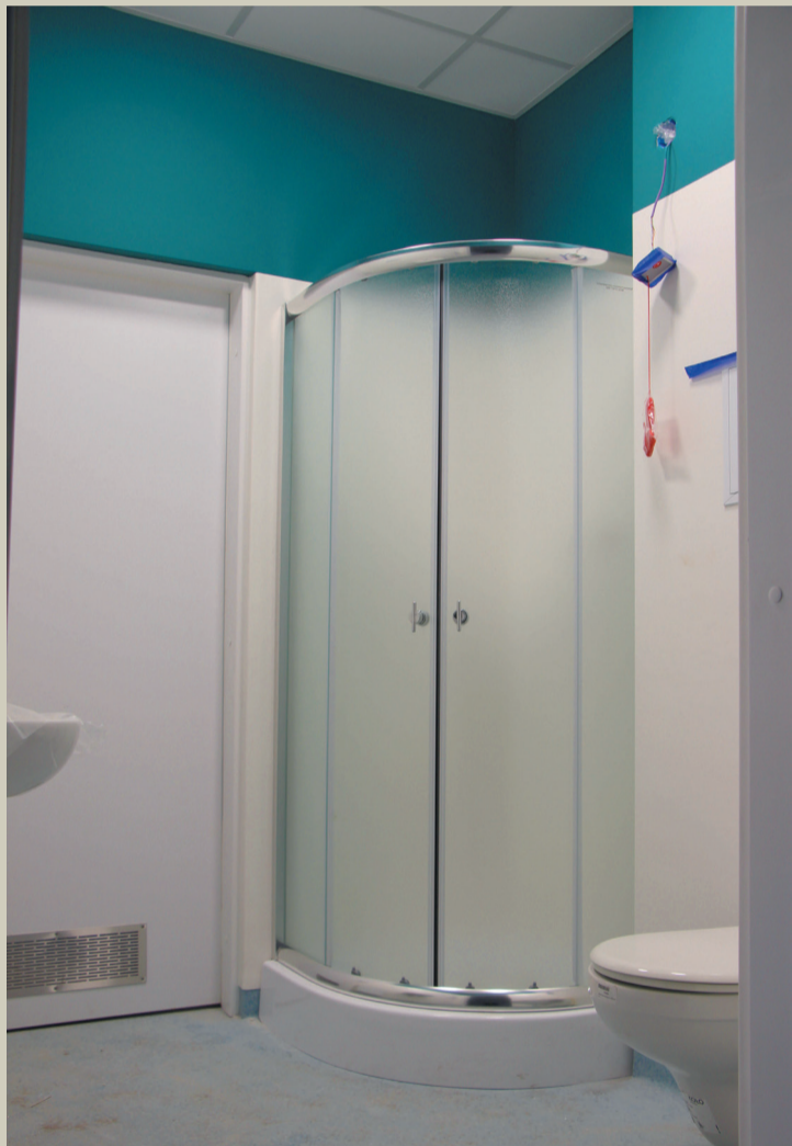
Instalacja armatury łazienkowej
