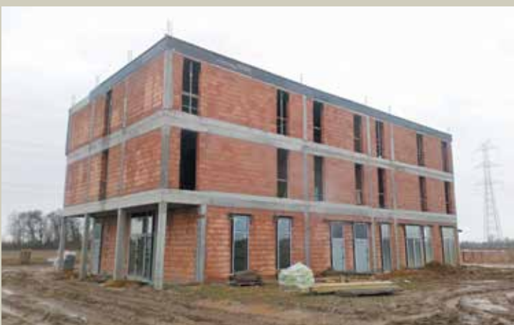
Montaż stolarki zewnętrznej
