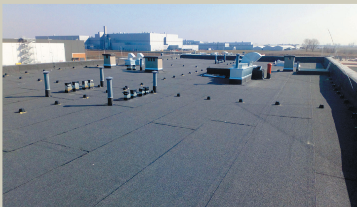
Roboty izolacyjne stropodachu
